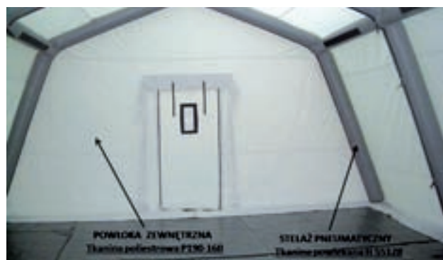
Ryc. 4. Stelaż pneumatyczny i powłoka zewnętrzna namiotu.
