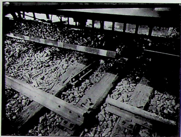
Ryc. 9. Zdjęcie przedstawiające miejsce rozkręconych szyn Fig. 9. Unscrewed rails
